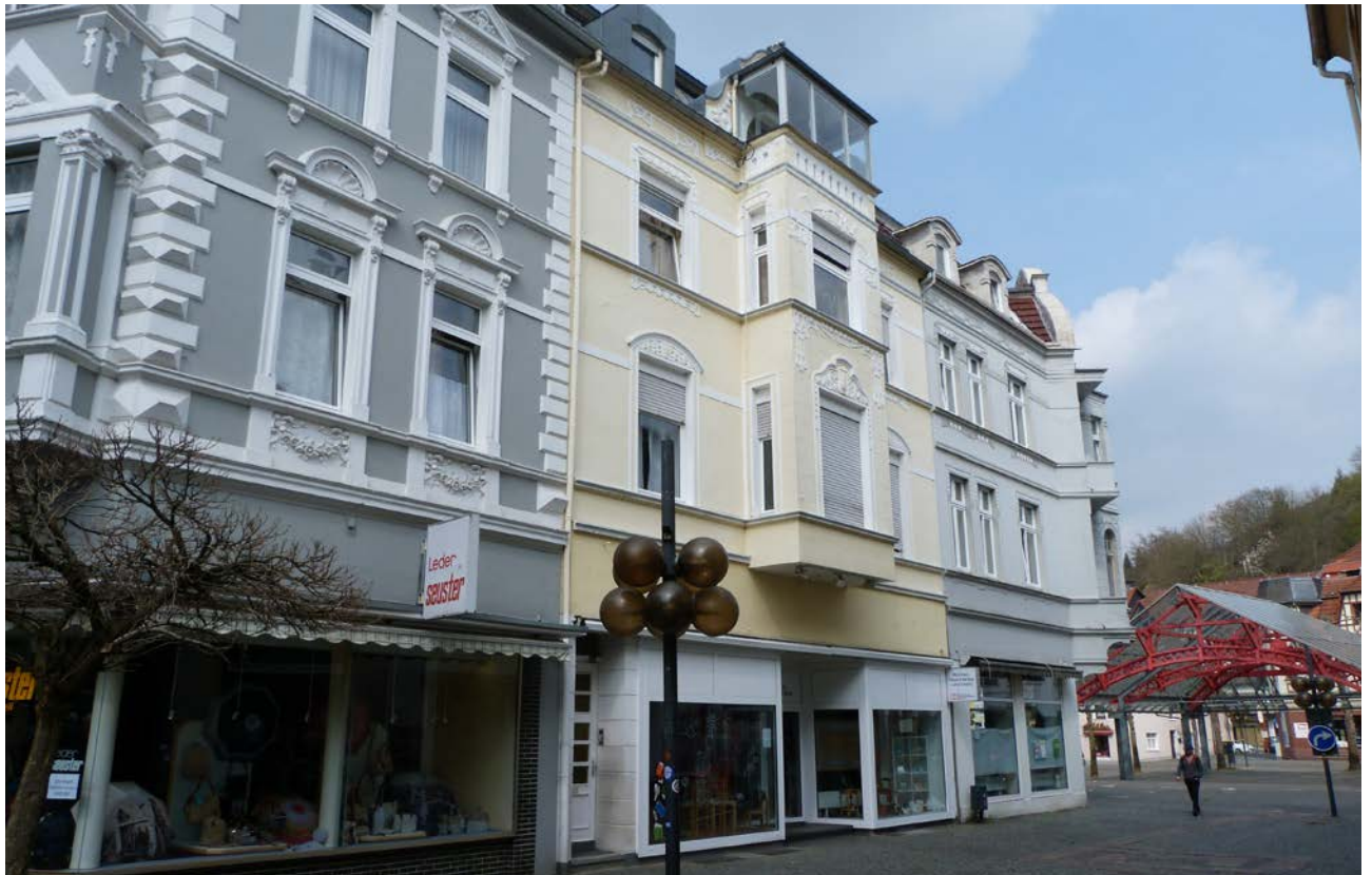
ABB 045 Transparente Erdgeschosszonen ohne Bezug zur Gesamtfassade
