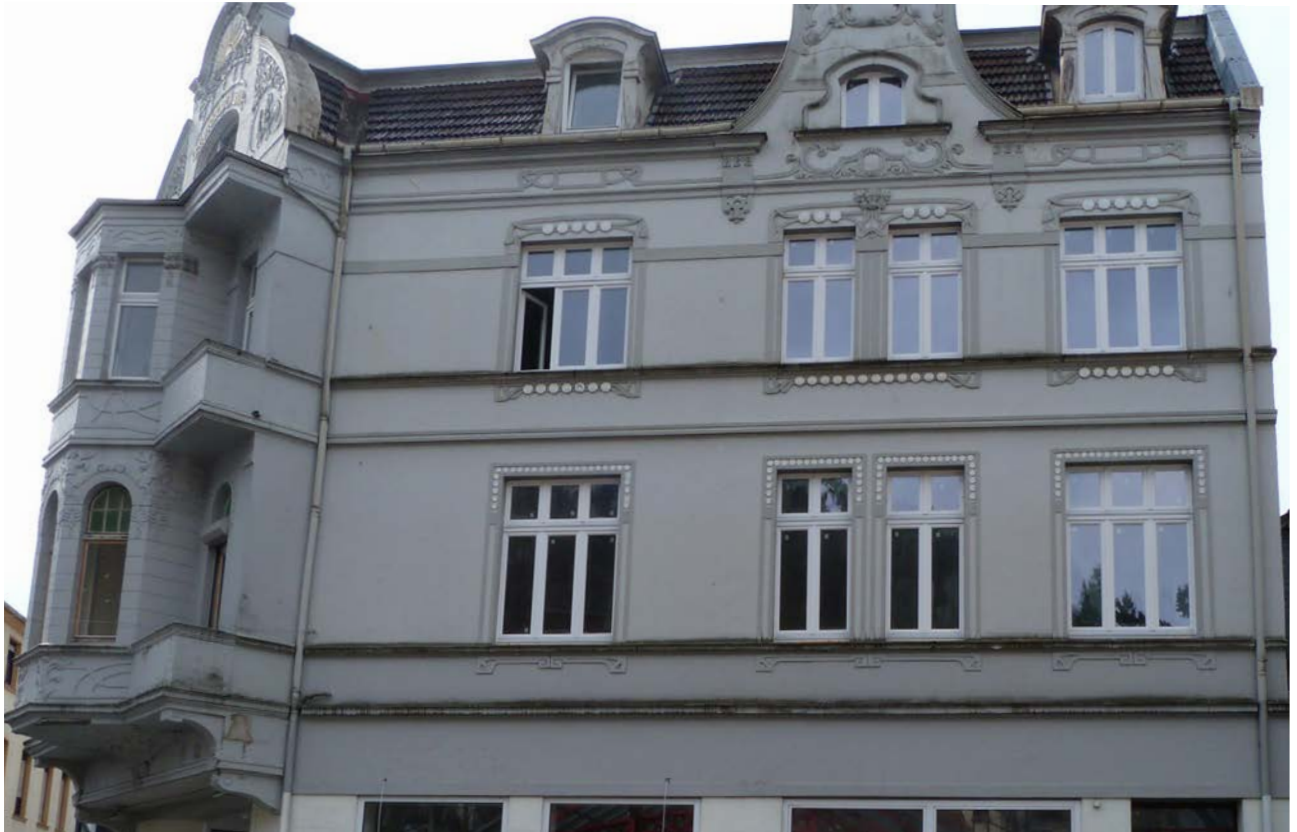
ABB 043 Gliederungselemente erhöhen die Plastizität der Fassade
