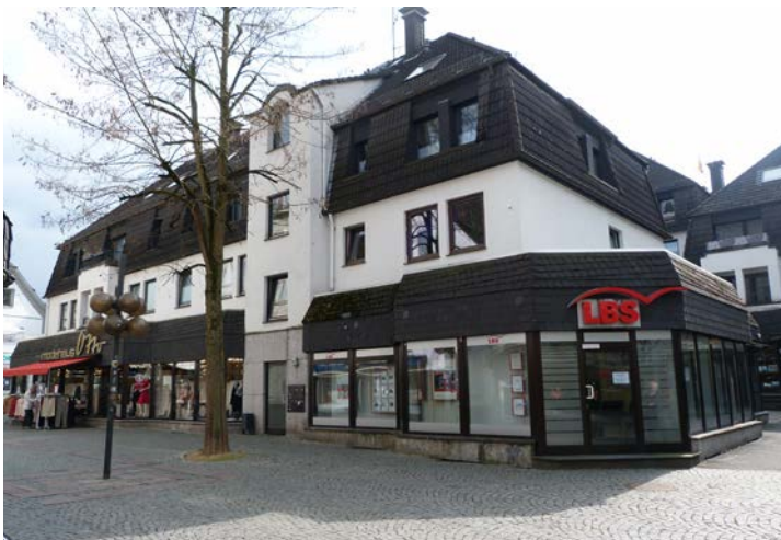
ABB 008 Bebauung aus der Zeit der Stadtsanierung aus den 1980er-Jahren an der Wilhelmstraße
