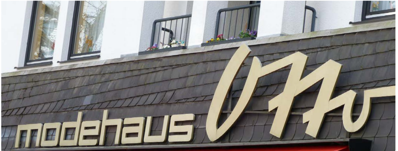
ABB 075 Werbeanlage an Schieferfassade
