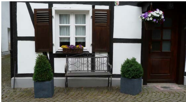
ABB 088 Verschiedene Möglichkeiten der Begrünung, ohne die Fassade zu dominieren
