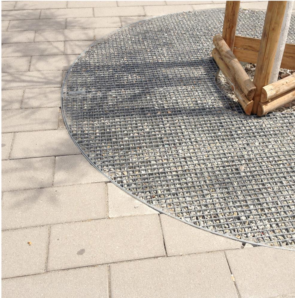
offene Baumscheiben mit Stahlbandeinfassung, Schotterabdeckung und Gitterrost
